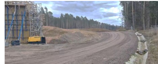
1 Bereich zwischen BW 9 und 10. Quelle: https://www.danni-lebt.de/un-recht/bau-arge/beprobung
